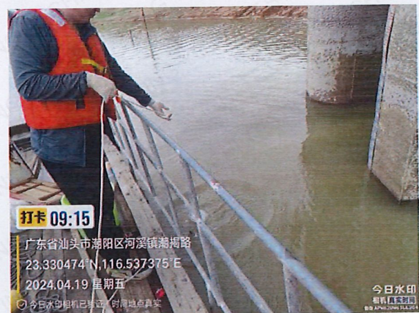
河溪水库取水口
